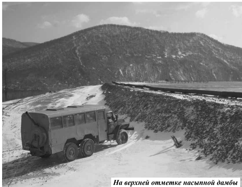
На верхней отметке насыпной дамбы
